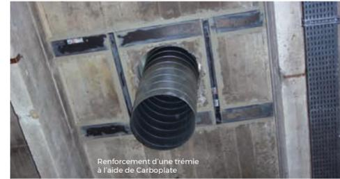
Renforcement d'une trémie à l'aide de CarboPlate
